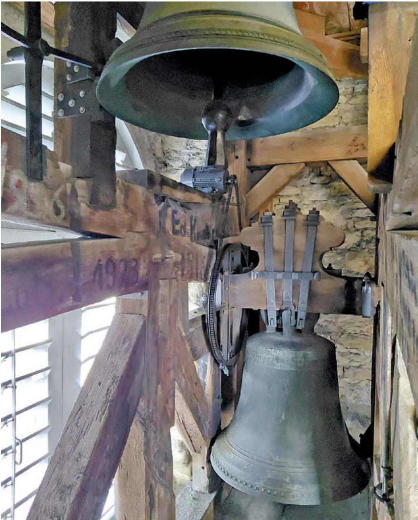
Die eindrücklichen, bald 200-jährigen Glocken sowie deren Aufhängung in der Kirche Oberrieden müssen revidiert werden.
